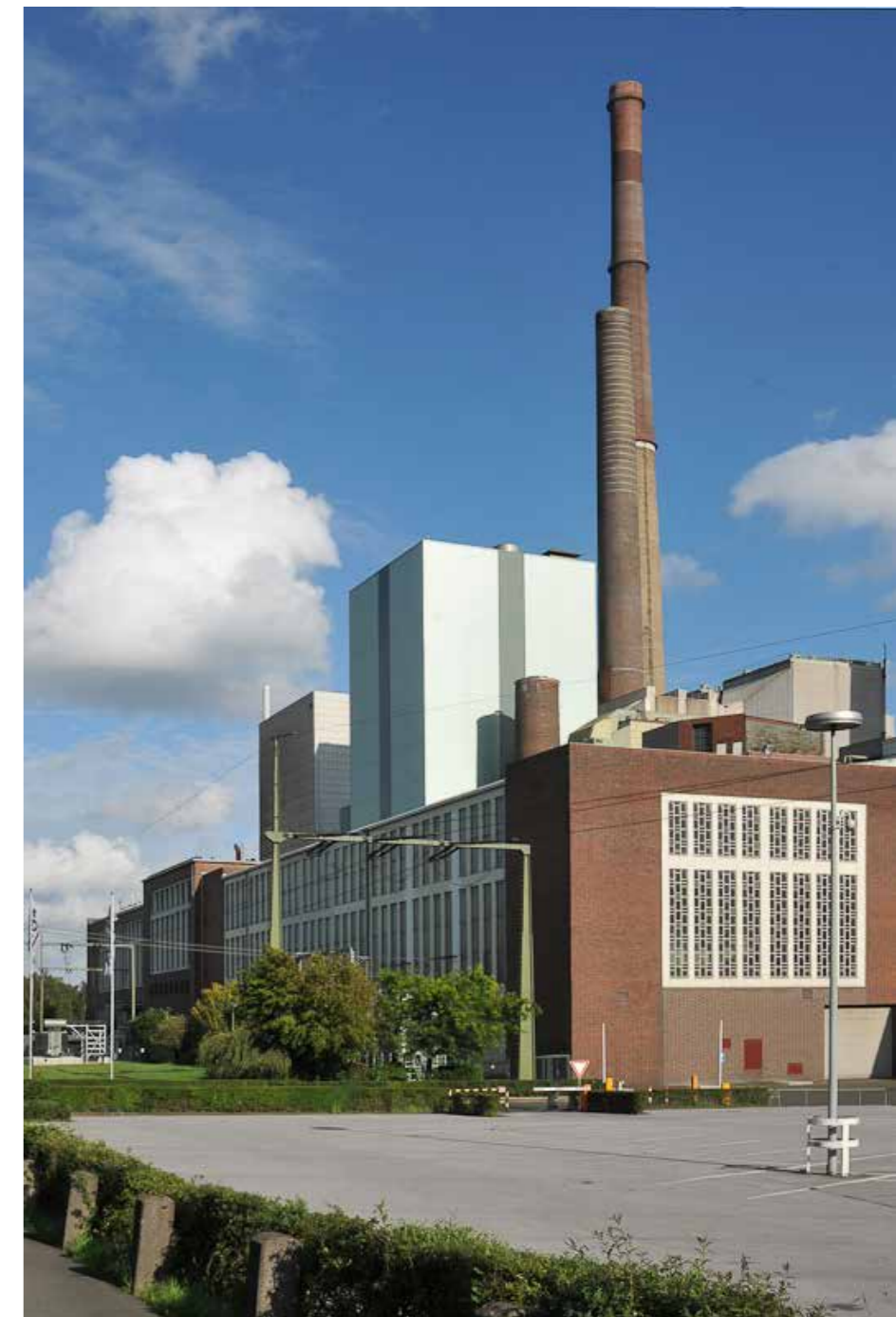
Kraftwerk Lünen. Foto: RIK/Budde
