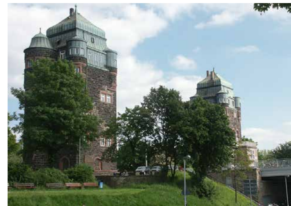
Friedrich-Ebert-Brücke. Foto: RIK/Walter
