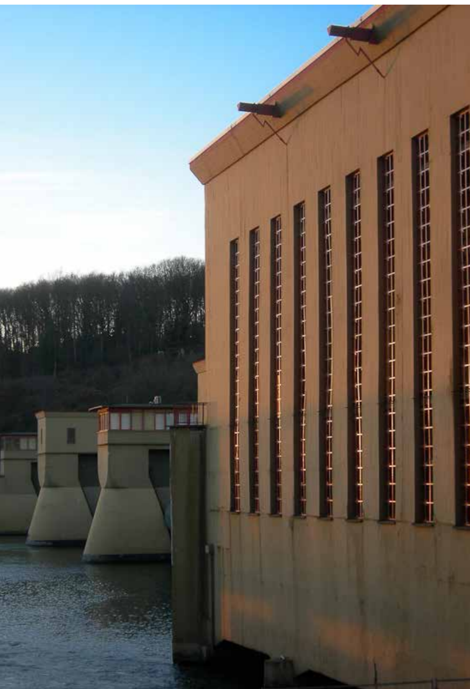
Laufwasserkraftwerk Hengstey. Foto: RIK/Budde
