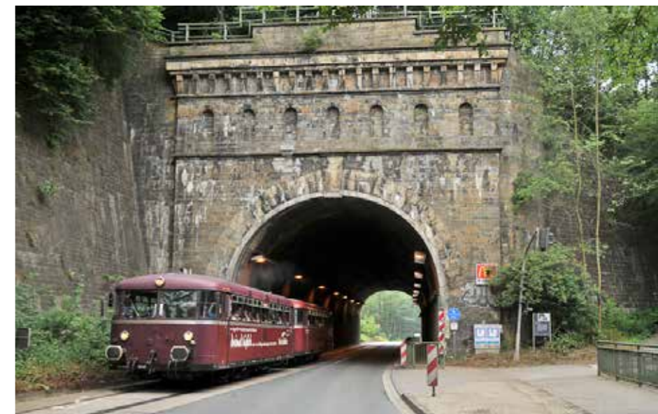
Kruiner Tunnel. Foto: RIK/Budde
