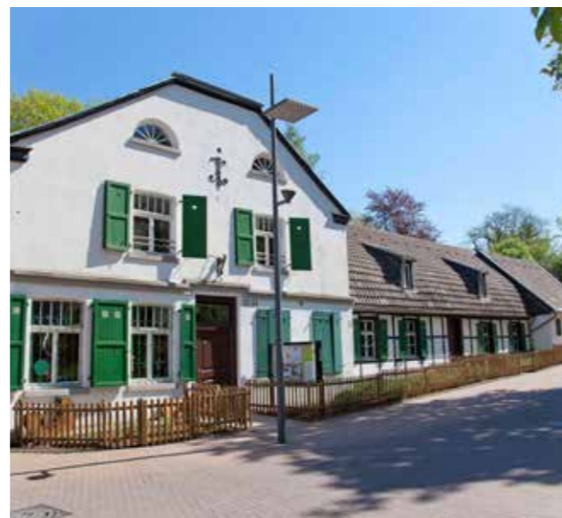
St. Antony-Hütte. Foto: LVR
