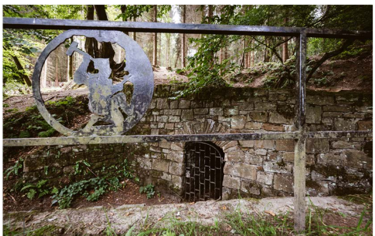
Eingang zum Stollen Stettin
